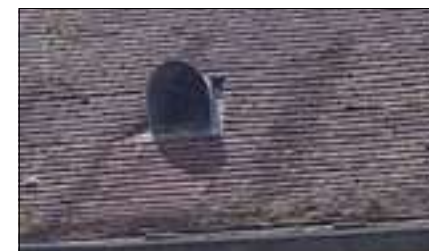
Petite aération de combles , ouvrage en zinc
