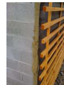
Principe d'isolation par l'extérieur finition par bardage tuiles
