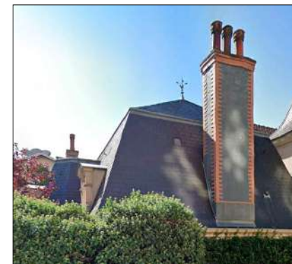
Conduit de fumée participant à l'aspect architectural de l'immeuble
