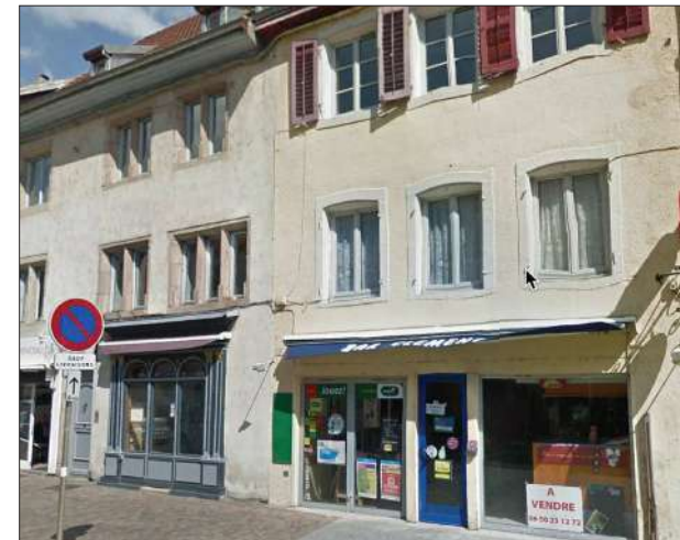
Maison particulière, rue Clémenceau
