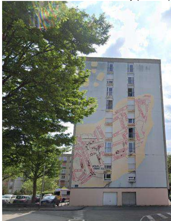
Démolition 26 Rue Claude Debussy (NEOLIA)
