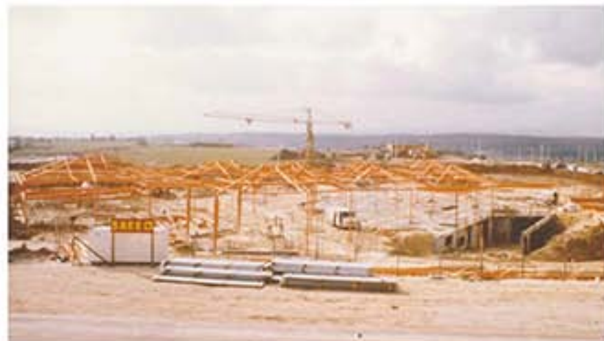
>> L'ossature des Hexagones. Bureau municipal de Montfermeil
