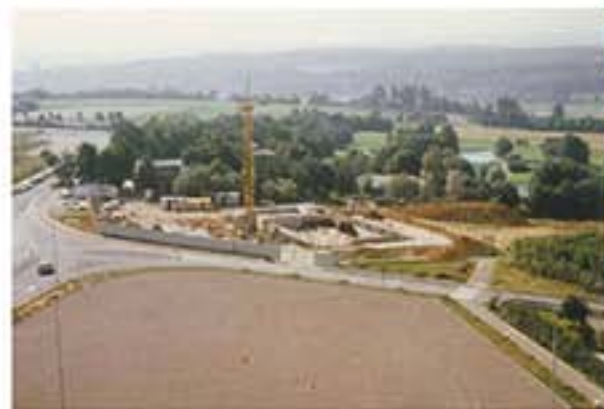
>> Construction de la piscine couverte. Archives municipales de Montbéliard
