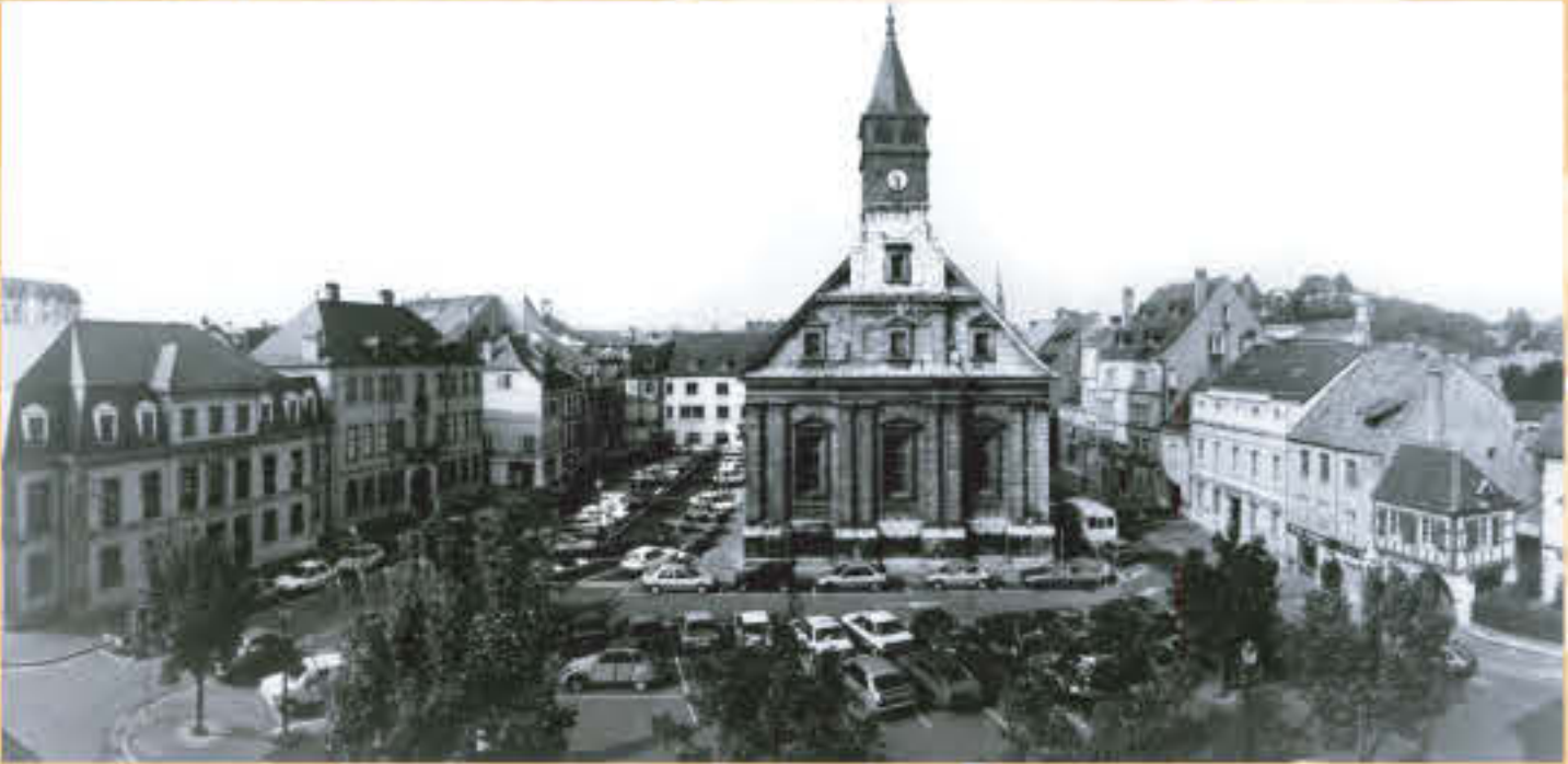
Le temple avant nettoyage et restauration des façades Photothèque Archives municipales de Montbéliard
