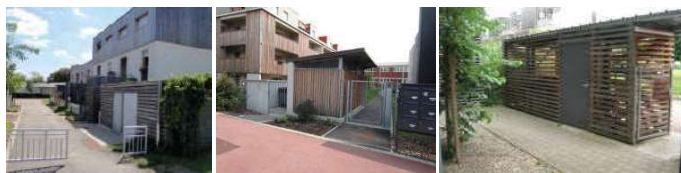
Intégration qualitative des locaux poubelles et vélos dans l'architecture du bâtiment (ici structure métallique et bardage bois ajouré)
